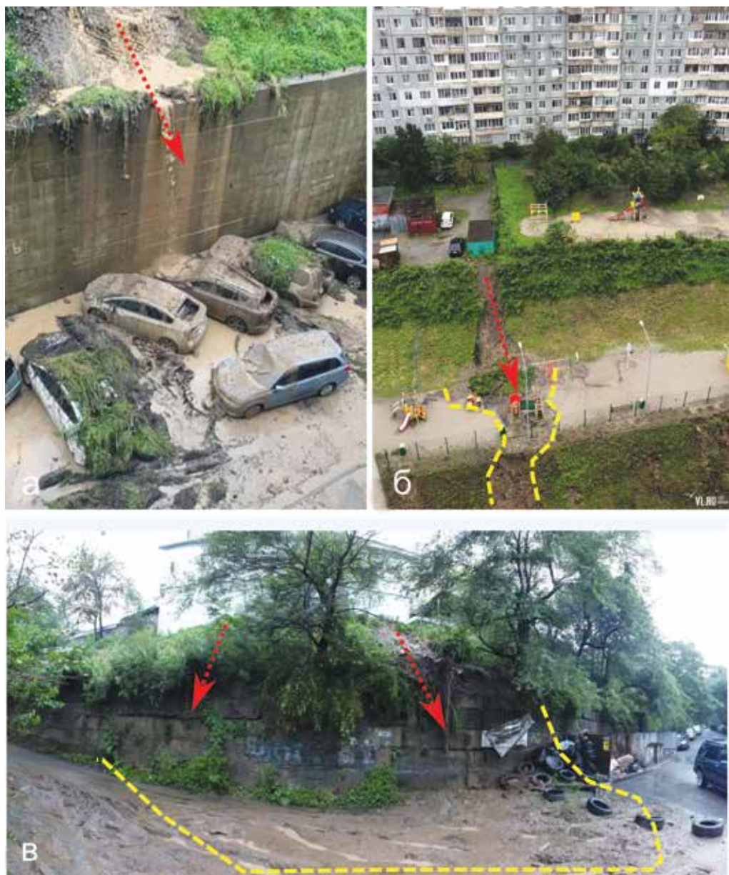
Рис. 4. Оползни на территории г. Владивосток: а – ул. Тобольская, 11; б – ул. Сафонова, в – ул. Юмашева, 20. Фото ООО «ВЛ Новости» и А.А. Орехова
