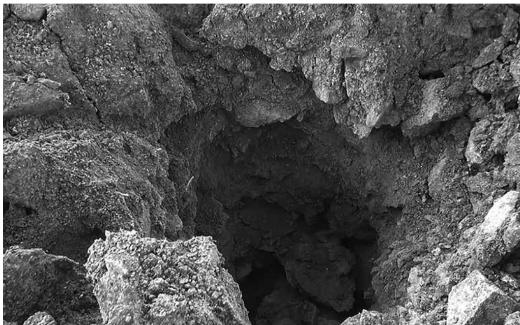
Рис. 4. Один из 100 шурфов – специальных скважин глубиной до 2,5 м, в которые закладывали тротил. Фото Минобороны РФ
