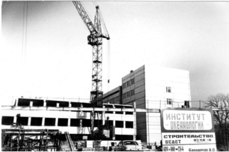
Строительство нового здания ТОИ ДВО РАН (1991 г.)
